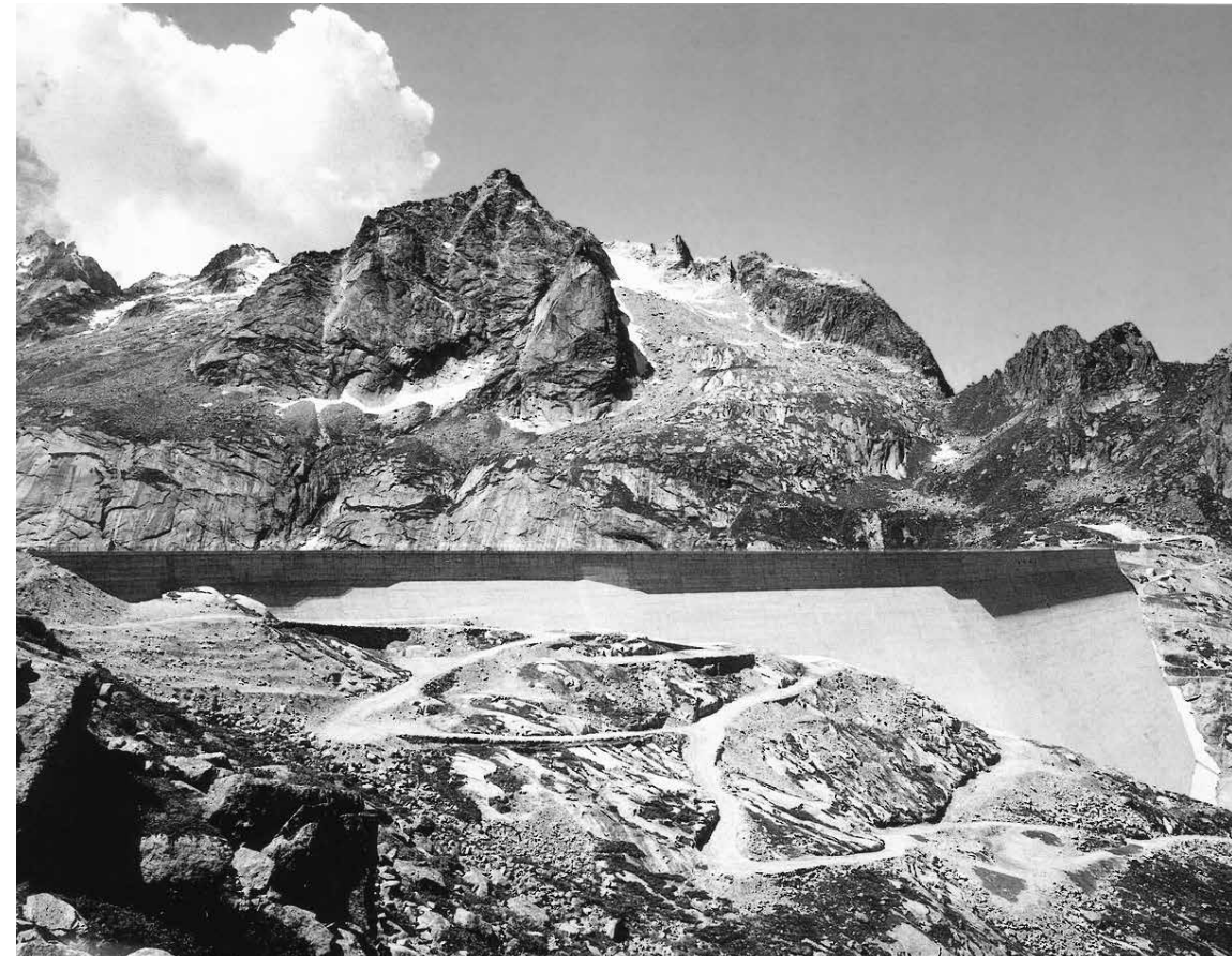
Staumauer Albigna, 2100 m ü. M., erbaut vom EWZ, 1955–59 (in: Clavuot/Ragetti, Die Kraftwerkbauten im Kanton Graubünden).
